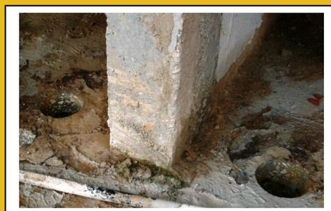
No global, foram executadas 407 colunas de jet-grouting com diâmetros de  $\varnothing 600$  mm e  $\varnothing 1000$  mm, 301 das quais eram verticais e 106 eram inclinadas a  $20^\circ$  e executadas posteriormente às verticais. Para tal, procedeu-se previamente à carotagem de 268 carotes em betão armado com diâmetro de  $\varnothing 150$  mm, 211 dos quais foram verticais e 155 foram inclinados a  $20^\circ$ .
